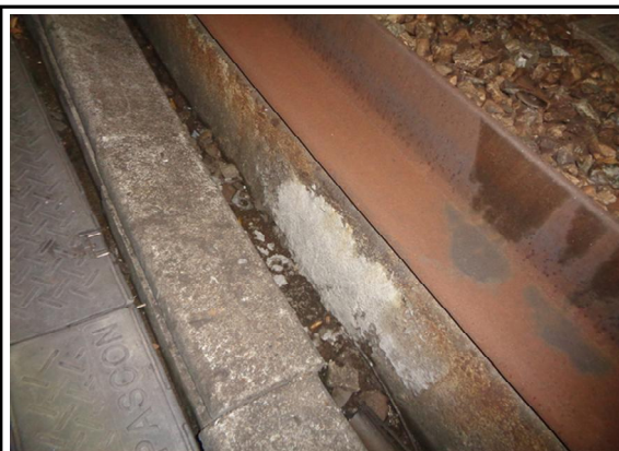
철근노출 및 박락 보수 (S7-외선)
