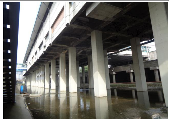
대림역하부 교각 전경
