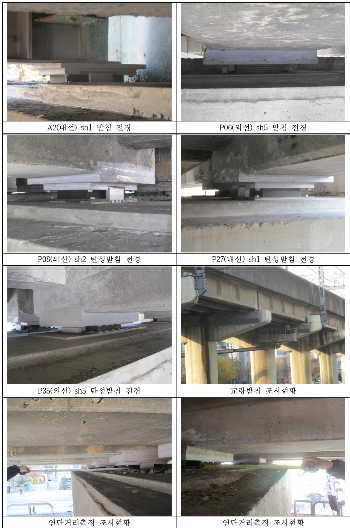
【그림 II-3.3.16】 교량받침 현황 및 조사 전경
