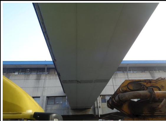
대림역 3,4번 출입구 하부 상태양호
