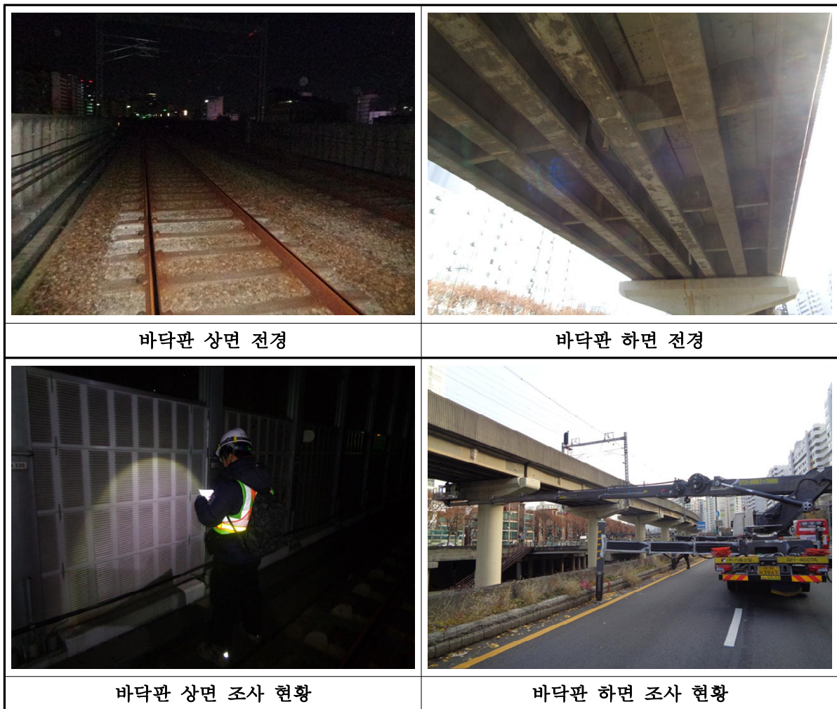
【그림 II-3.3.1】 바닥판 현황 및 조사 전경
