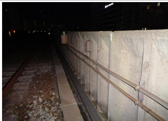
콘크리트 방음벽 내측 전경
