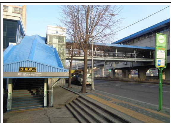
대림역 3,4번 출입구 설치 현황
