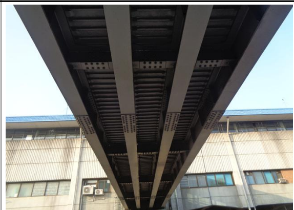
대림역 7,8번 출입구 하부 상태양호
