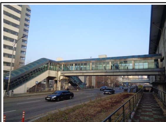
대림역 1,2번 출입구 설치 현황
