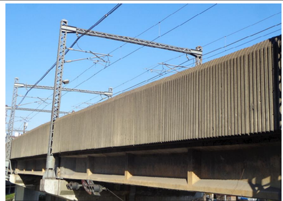
콘크리트 방음벽 외측 전경
