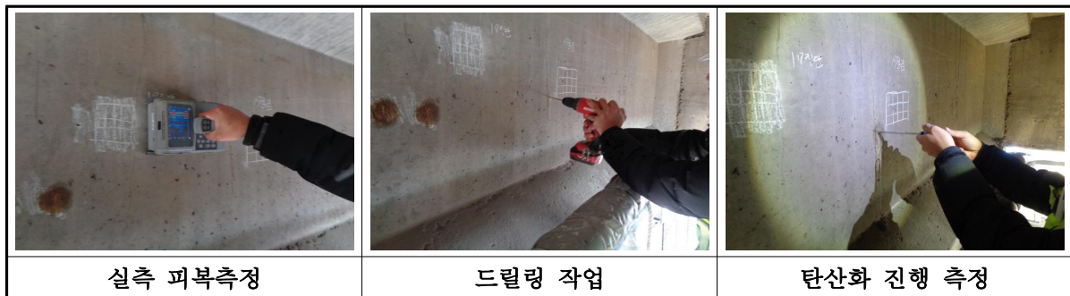
【그림 II-3.3.31】 탄산화 깊이 측정 절차
