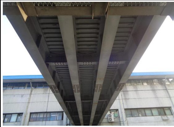
대림역 1,2번 출입구 하부 상태양호
