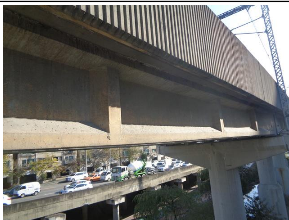
PSC 거더 전경
