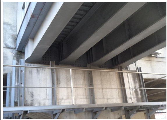
대림역 1,2번 출입구 하부 상태양호
