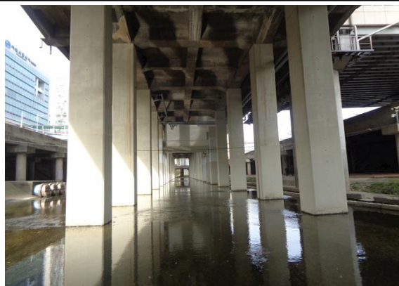
대림역하부 바닥판 전경
