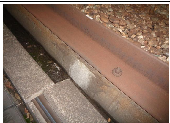
철근노출 및 박락 보수 (S9-외선)
