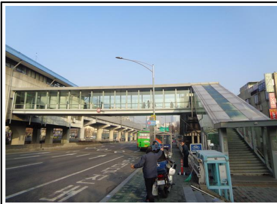
대림역 5,6번 출입구 설치 현황
