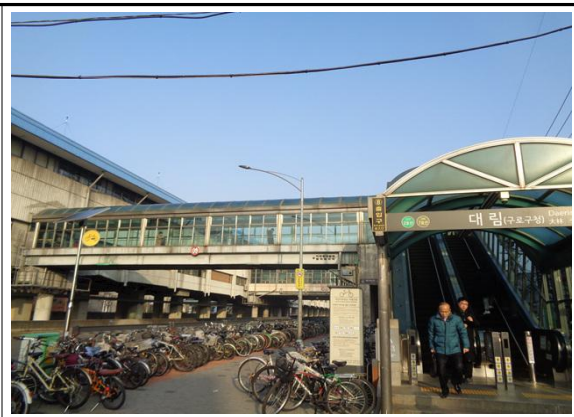
대림역 7,8번 출입구 설치 현황
