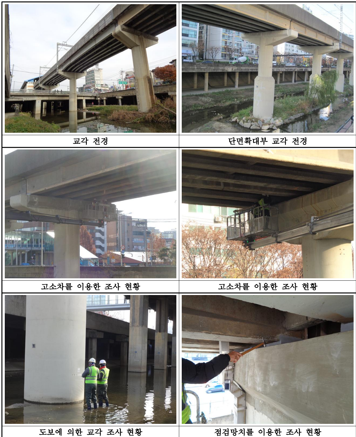
【그림 II-3.3.9】 하부구조 현황 및 조사 전경
